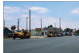
Repavimentación de Pavimentos
