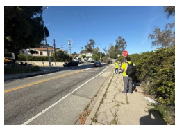
Aceras grietas y estrechas
